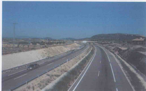
Autovía del Noroeste- Río Mula: Una Infraestructura viaria que ha mejorado considerablemente la integración Regional aunque de forma parcial
