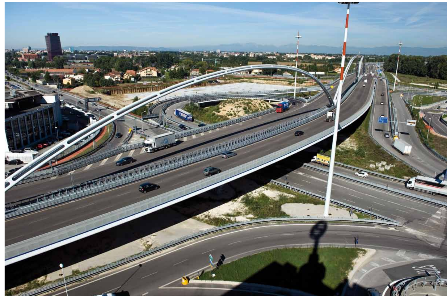
1. Padua este (Veneto), nudo intermodal. Las obras realizadas para mejorar la viabilidad y la ordenación urbanística de la ciudad fragmentan y transforman irreversiblemente el paisaje rural adyacente. (VENETO 2, VEN-7)
